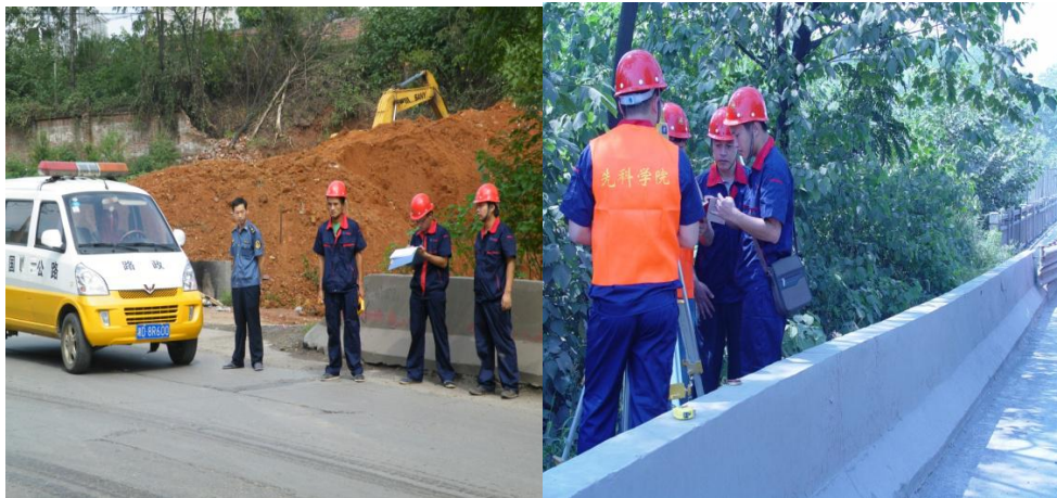
工学交替 师徒对来阳 107 国道万人亭桥检测
